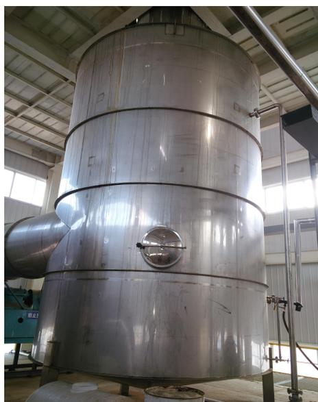
图 3-4 水膜除尘器和 UV 光催化净化器
